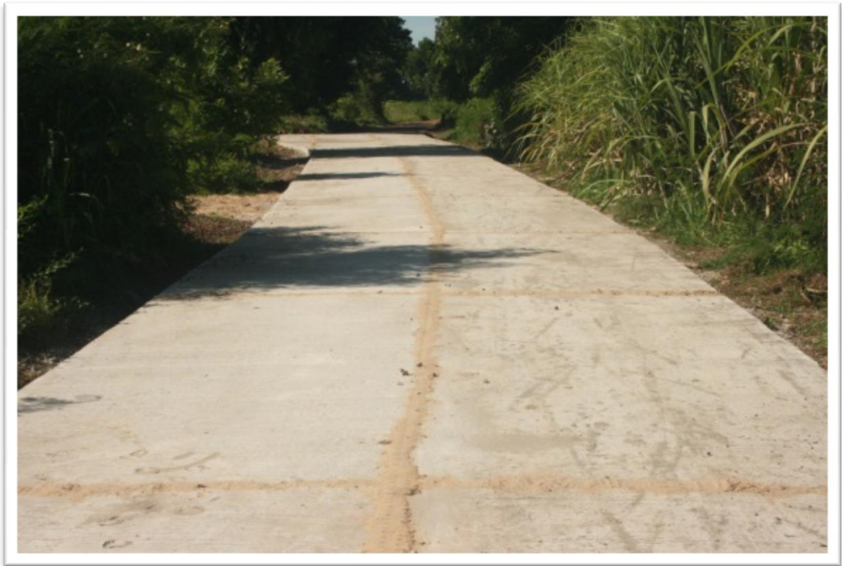
หลังดำเนินการก่อสร้างถนนคอนกรีตเสริมเหล็ก
