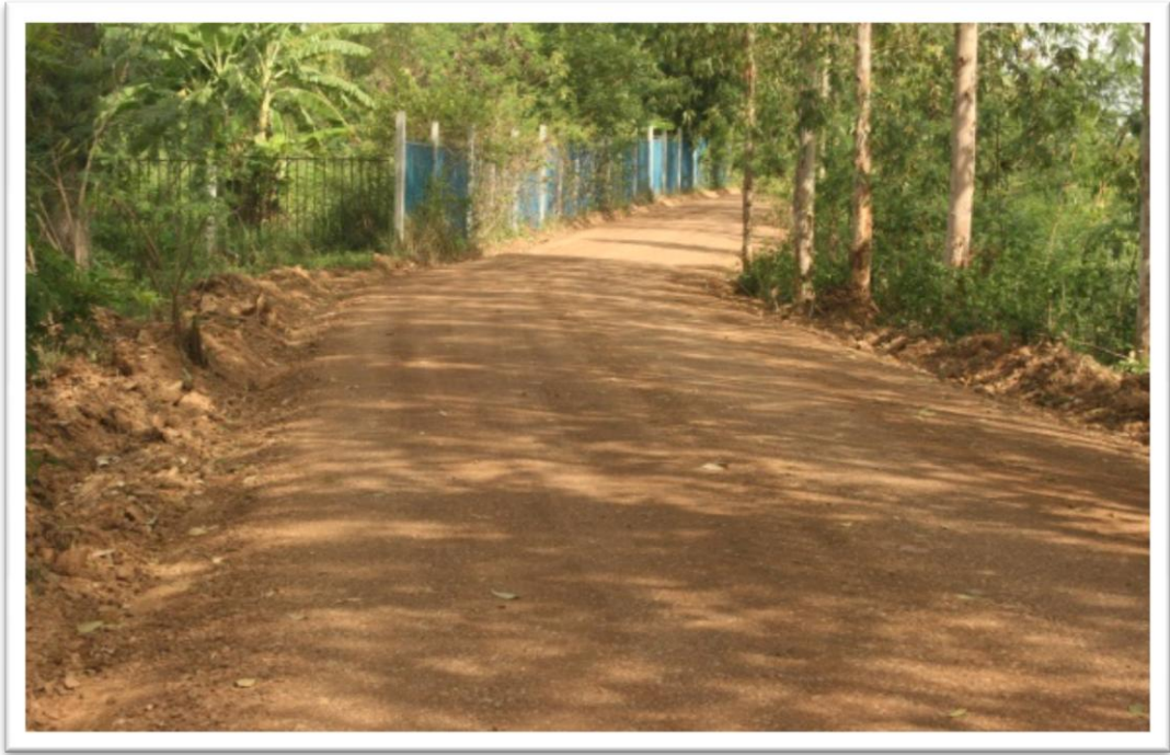
หลังดำเนินการปรับปรุงถนนลงหินคลุก
