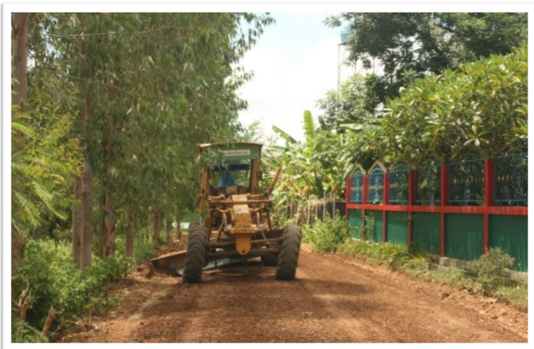
ระหว่างดำเนินการปรับปรุงถนนลงหินคลุก
